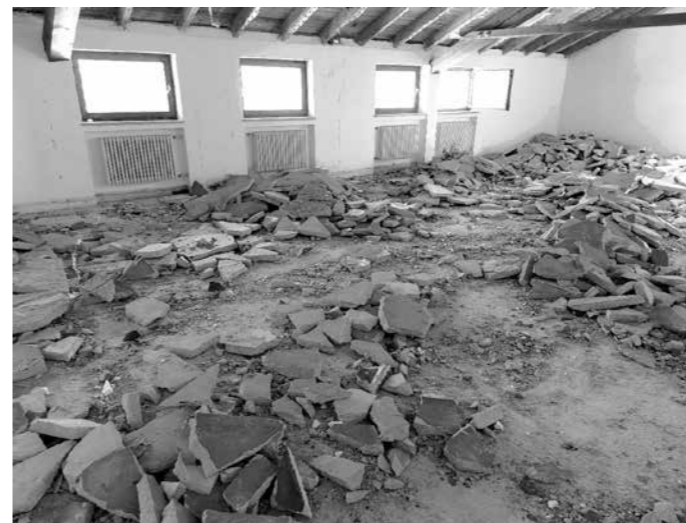
12.08.2022 – der Estrich im Gymnastikraum / 1. OG wird herausgebrochen
