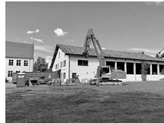
15.08.2022 – der Bagger kommt, am 17.08 geht's los.
