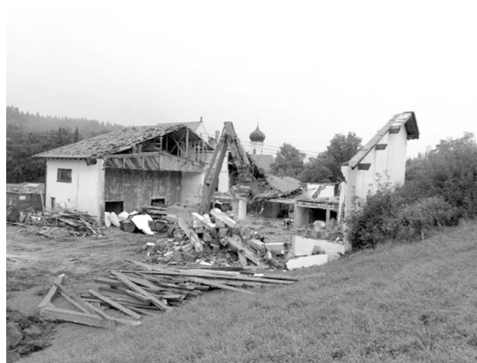
19.08.2022 – die Halle und der Gymnastikraum sind schon weg
