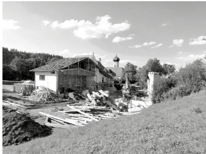
22.08.2022 – nur der vordere Teil der Halle steht noch
