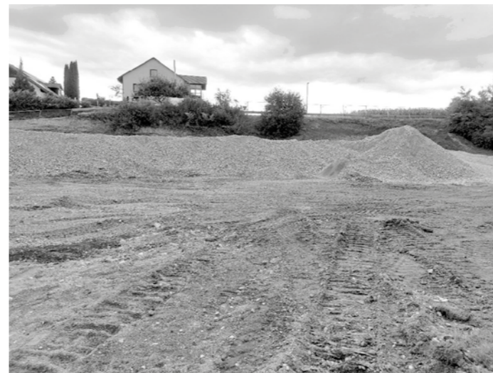
03.09.2022 – Die Fläche ist frei, nun geht es an den Rohbau
