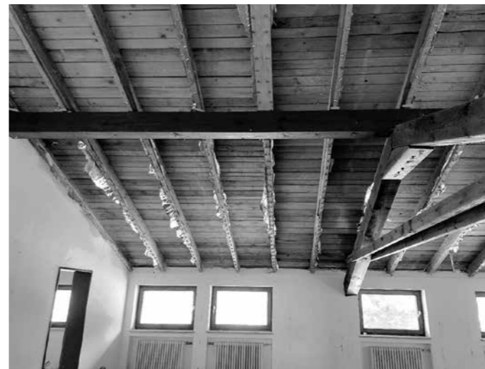
12.08.2022 – die Decke vom Gymnastikraum fehlt schon
