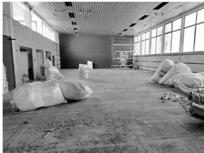
08.08.2022 – der Hallenboden fehlt schon, die Isolierung an den Wänden und vom 1. OG ist tws. Auch schon weg.
