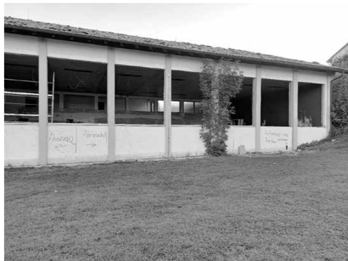
12.08.2022 – Die Fenster der Mehrzweckhalle wurden ausgebaut
